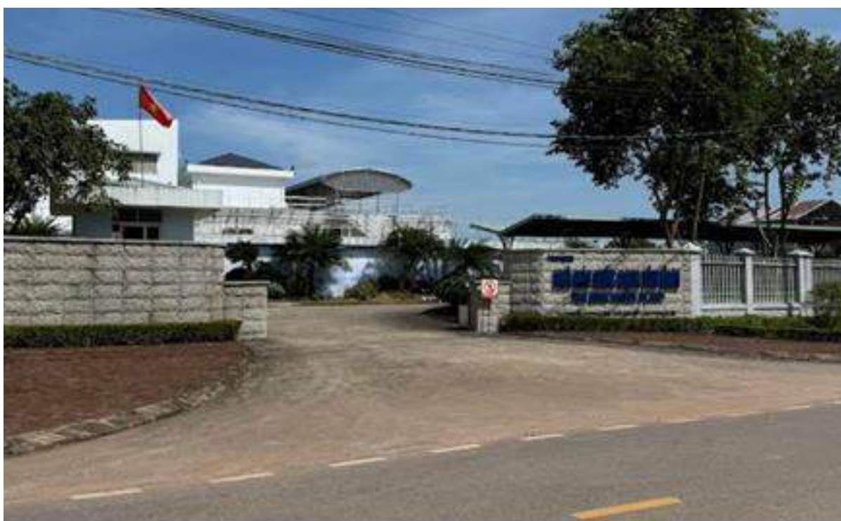
Hình 1. 6: Nhà máy nước Yên Bình
